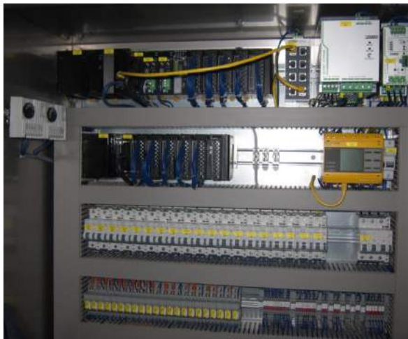
船上配電盤照片，左圖右側黃色設備為直流漏電裝置
